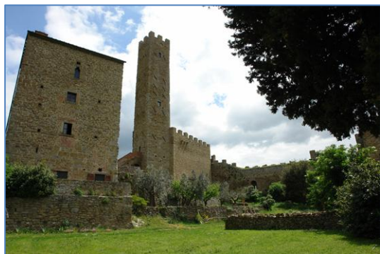
fig. 25 - Castello di Montecchio Vesponi. Veduta interna della porzione sud-occidentale della superficie castellana.
