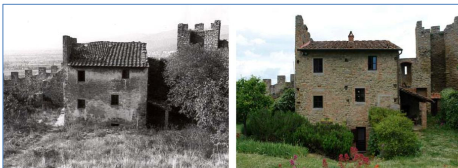
fig. 32 - L'abitazione di Montecchio., veduta del prospetto meridionale prima e dopo gli interventi di restauro degli anni '80 del secolo scorso.
