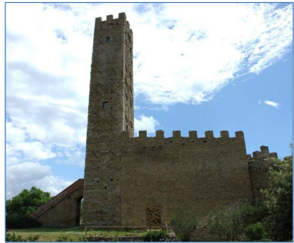
fig. 30 - Il cassero di Montecchio, veduta del prospetto occidentale.
