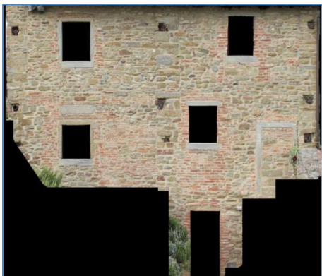
fig. 42 - CF 4, ortofotomosaico del prospetto meridionale creato tramite Z-Map.
