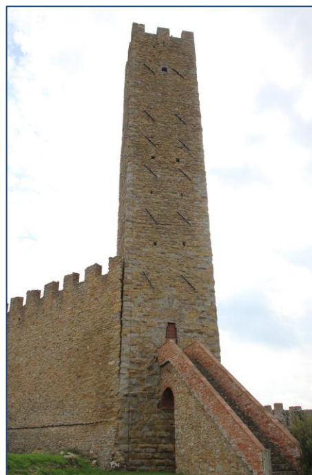
fig. 53 - La torre del castello, CF 1. Veduta della parte settentrionale del corpo di fabbrica.
