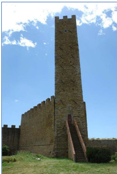
fig. 29 - La torre di Montecchio, veduta del prospetto settentrionale.
