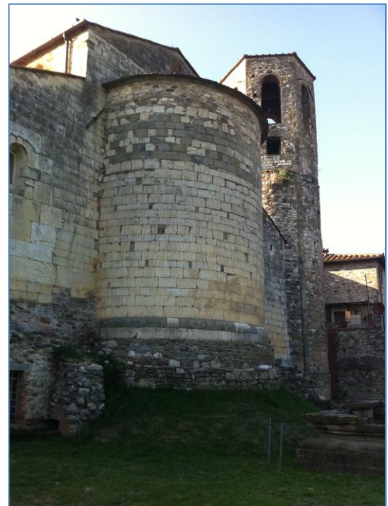
fig. 21 - Pieve di Socana, Castel Focognano (AR). Veduta prospettica della porzione absidale dell'edificio ecclesiastico.
