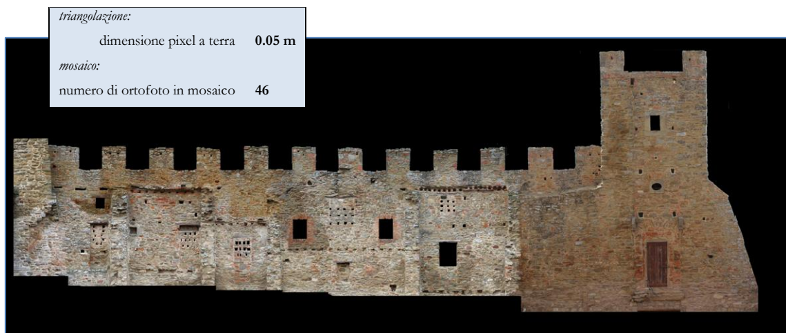
fig. 63 - CF W, ortofotomosaico del prospetto murario creato tramite Z-Map.
