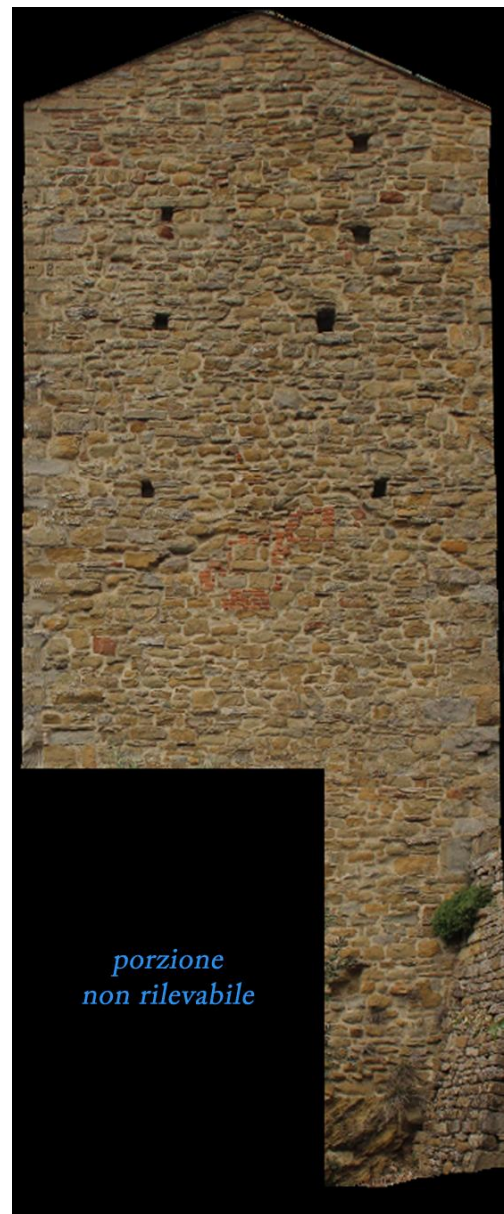
fig. 52 - CF 3, ortofotomosaico del prospetto meridionale creato tramite Z-Map.
