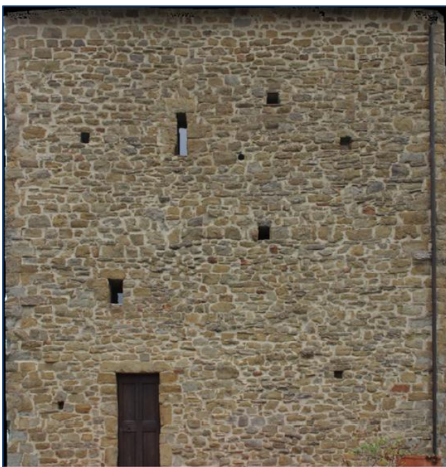
fig. 51 - CF 3, ortofotomosaico del prospetto orientale creato tramite Z-Map.
